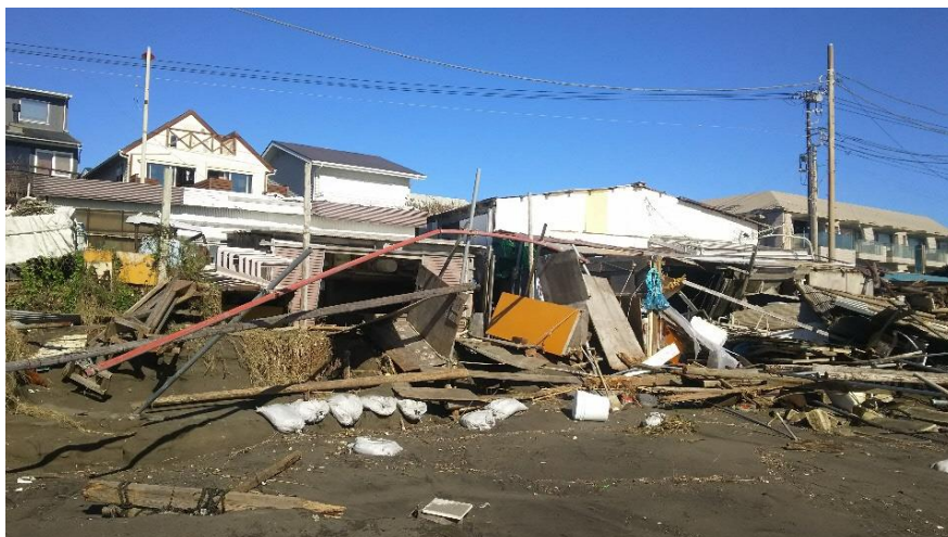
〔材木座地区の漁具倉庫の被害状況〕
